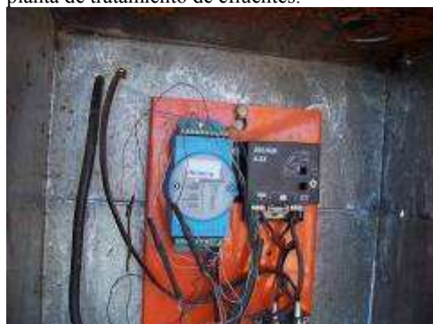
Figura 3: Sistema de Medición: módulo de adquisición de datos
