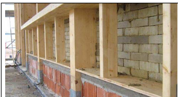
Figura 14: Detalle de la estructura de madera laminada aporticada. Tipología A.
