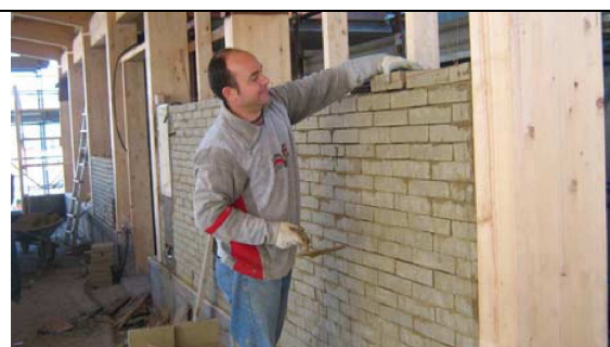
Figura 15: Detalle de muro en tierra cruda. Tipología A.
